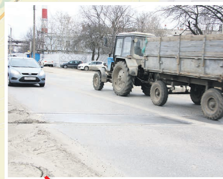
● На антоповской дороге протяжённостью всего 2,3 км находится три железнодорожных переезда. Они очень сильно замедляли движение, ведь автомобилям приходилось притормаживать, проезжая через них. Сейчас эти зоны выровнены по высоте дорожного полотна. Даже автомобили с низкой посадкой легко справляются с препятствием, скорость прохождения пути увеличилась — напряжённость снизилась.
